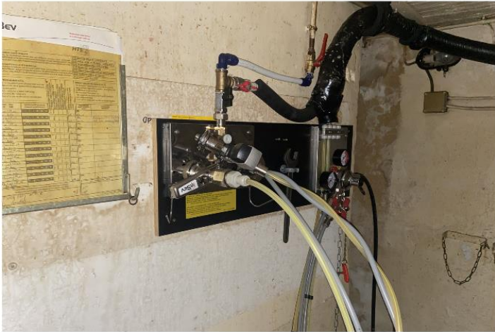
Kelder Aansluiting voor vaten
